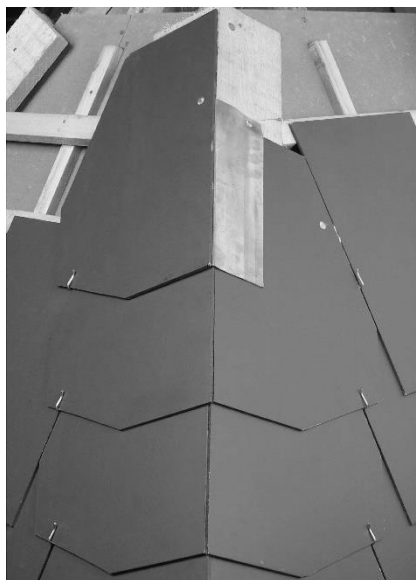
Foto 3: Hoekkeper met versneden schuine leien
