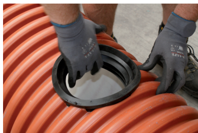
Plaatsen rubberen dichting (zonder glijmiddel)
