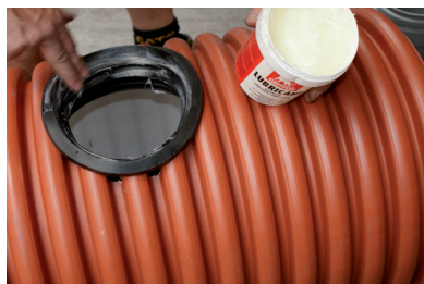
Aanbrengen glijmiddel aan de binnenzijde van de rubberen dichting
