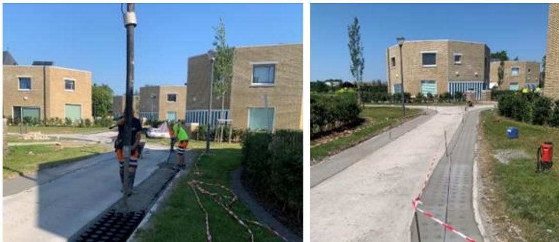
Après un temps de durcissement minimum de 48 heures, les opercules du Drainix® peuvent être retirés, soit par une méthode thermique, soit mécaniquement.
